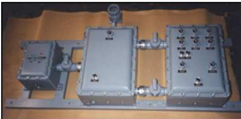
Figura 7.3 - Quadro di comando realizzato in esecuzione a prova di esplosione - visto dall'esterno (Ghirardi)
