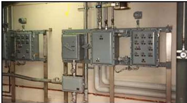
Figura 18.3 - Esempio di impianto realizzato in tubo. Si notano tra una custodia e l'altra i raccordi di bloccaggio (Ghirardi)
